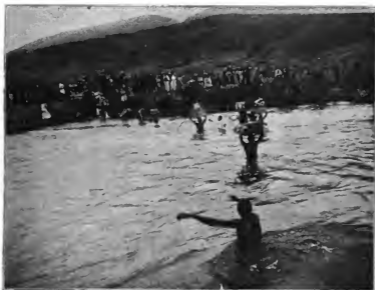
Trägertonne beim Flußübergang.
